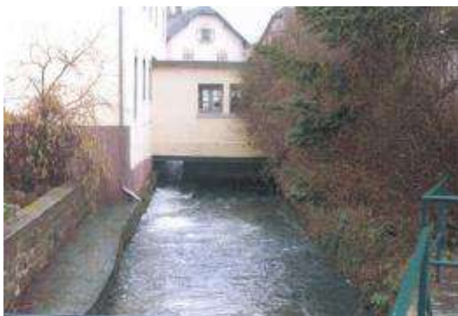
Muhlbeh en aval du Moulin (avant travaux)
