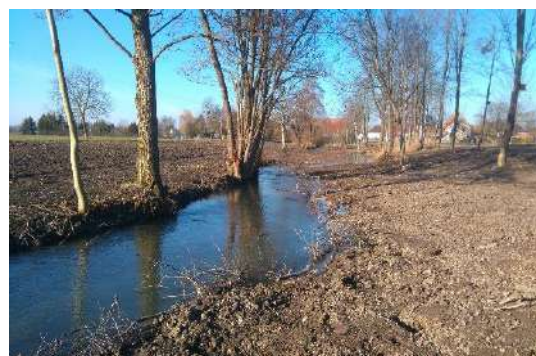
Mise en œuvre de banquettes-peignes avec recouvrement de terre
