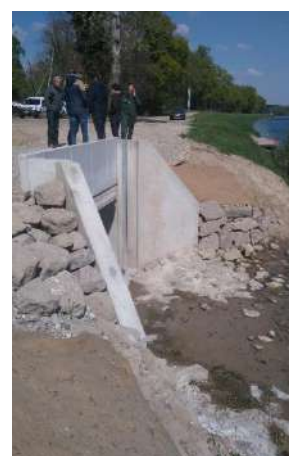
Nouvelle prise d'eau amont
