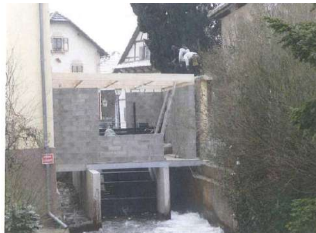
Muhlbeh en aval du Moulin (pendant les travaux)
