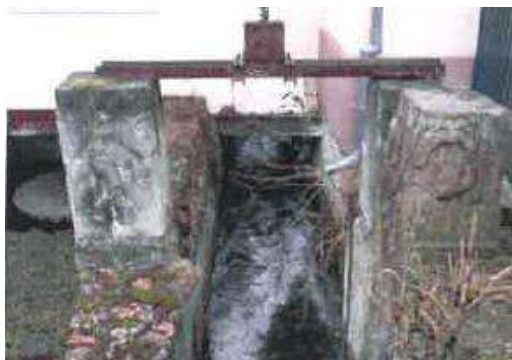
Ancien canal de décharge (emplacement actuel de la passe à poissons)
